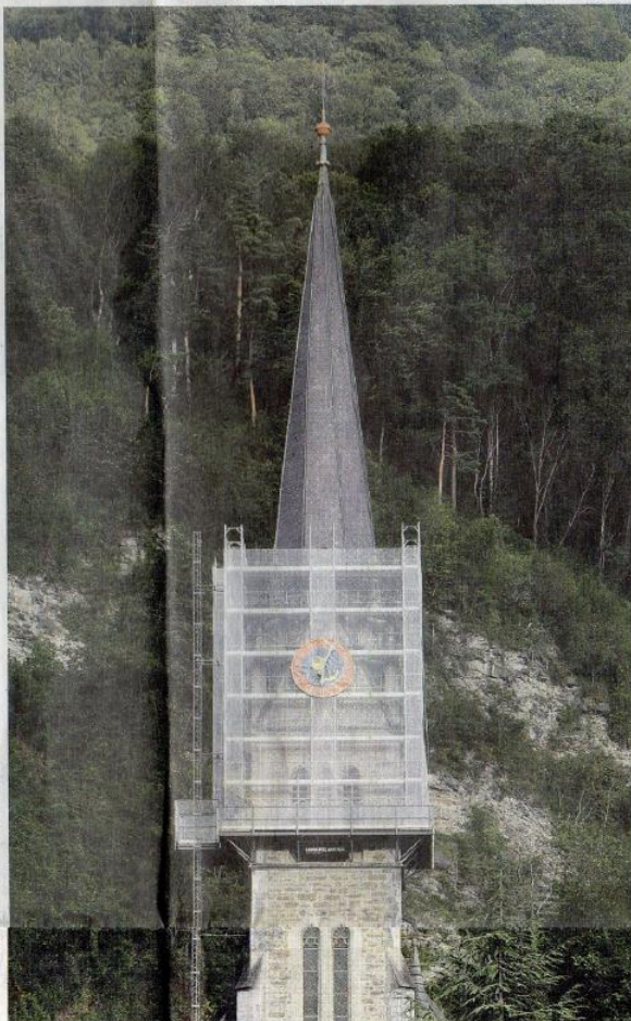
Seit Juli 2012 eingerüstet: Ende September soll die Sanierung des Kirchturms in Vaduz abgeschlossen werden.
