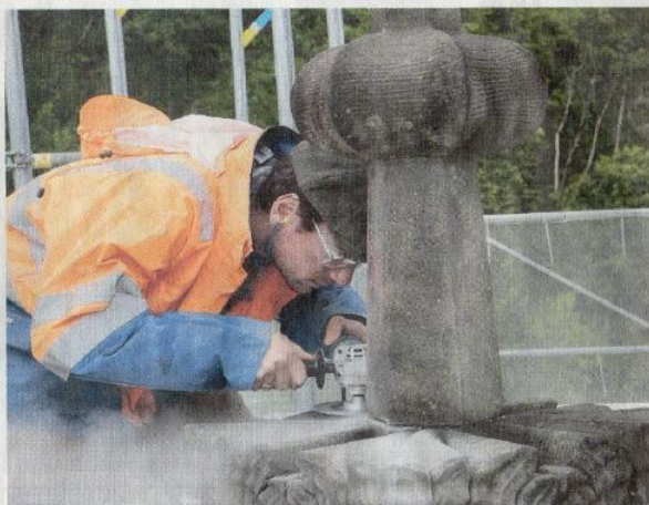
Die Arbeiten sind im Gange: Diese Woche wurde mit der Reinigung und Untersuchung der Steinfiguren begonnen.
