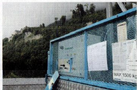
Hoch hinaus: Dank des Baulifts ist man in wenigen Minuten auf dem Kirchturm.
